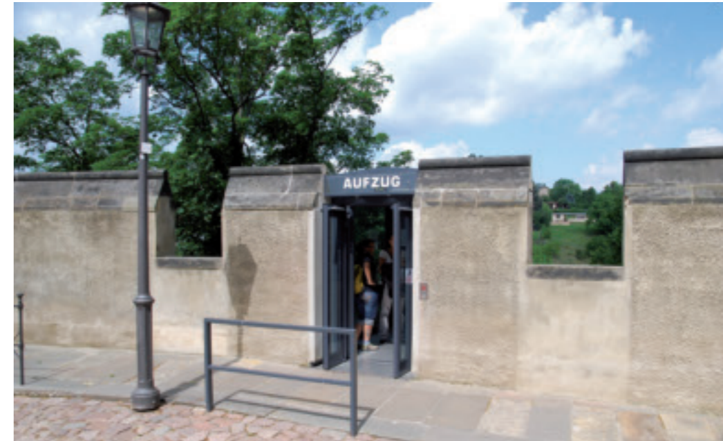
Domberg Meißen, rückseitige Erschließung mit Schrägaufzug vom Parkplatz aus. Bergstation (Foto: Thomas Will)
