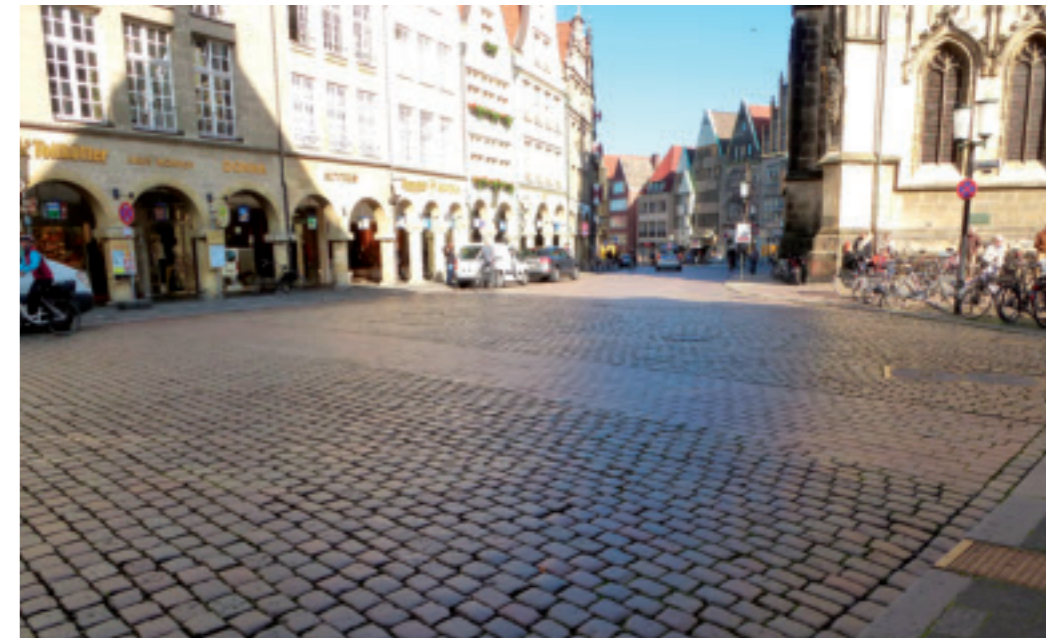
Prinzipalmarkt in Münster mit glattem Pflasterverbund an den Hauptquerungen (Foto: Michael Kappel)
