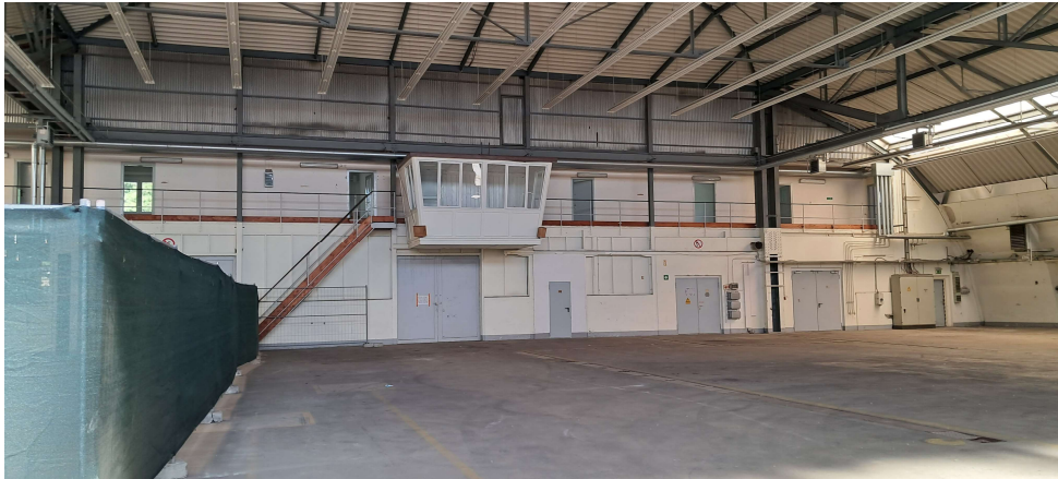
Abb.: Blick in Hangar 1; Quelle: DNK/ Tell
